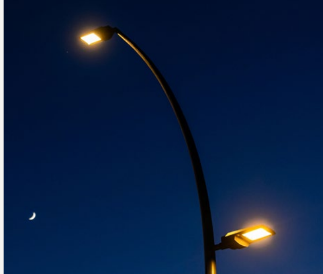
Instal·lació de nou enllumenat
