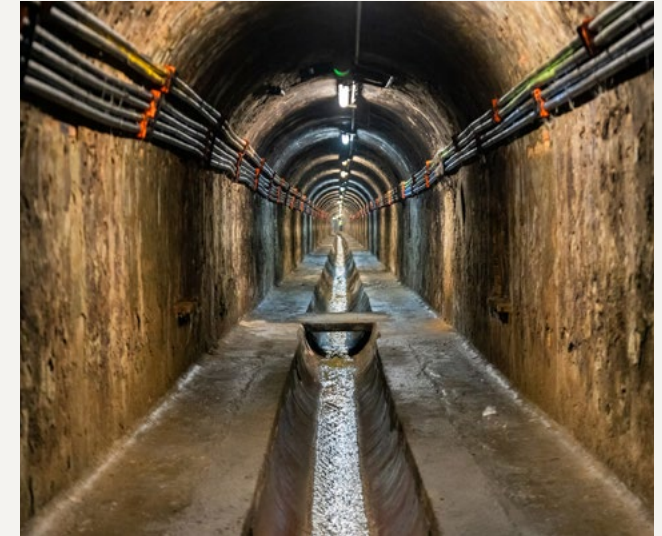
Renovació i reforma del clavegueram
