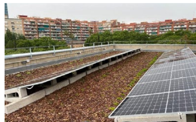
Exemple d'obra d'edificació on s'apliquen els criteris ambientals. CAI de la Marina: Actuació amb coberta verda, captació solar fotovoltaïques i certificació ambiental LEED.
