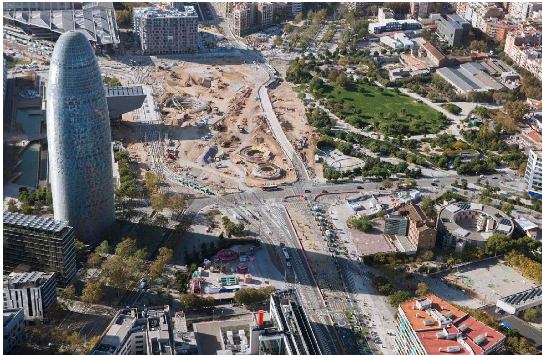
Plaça de les Glòries. Canòpia s/ Túnel Lots 1 i 2
