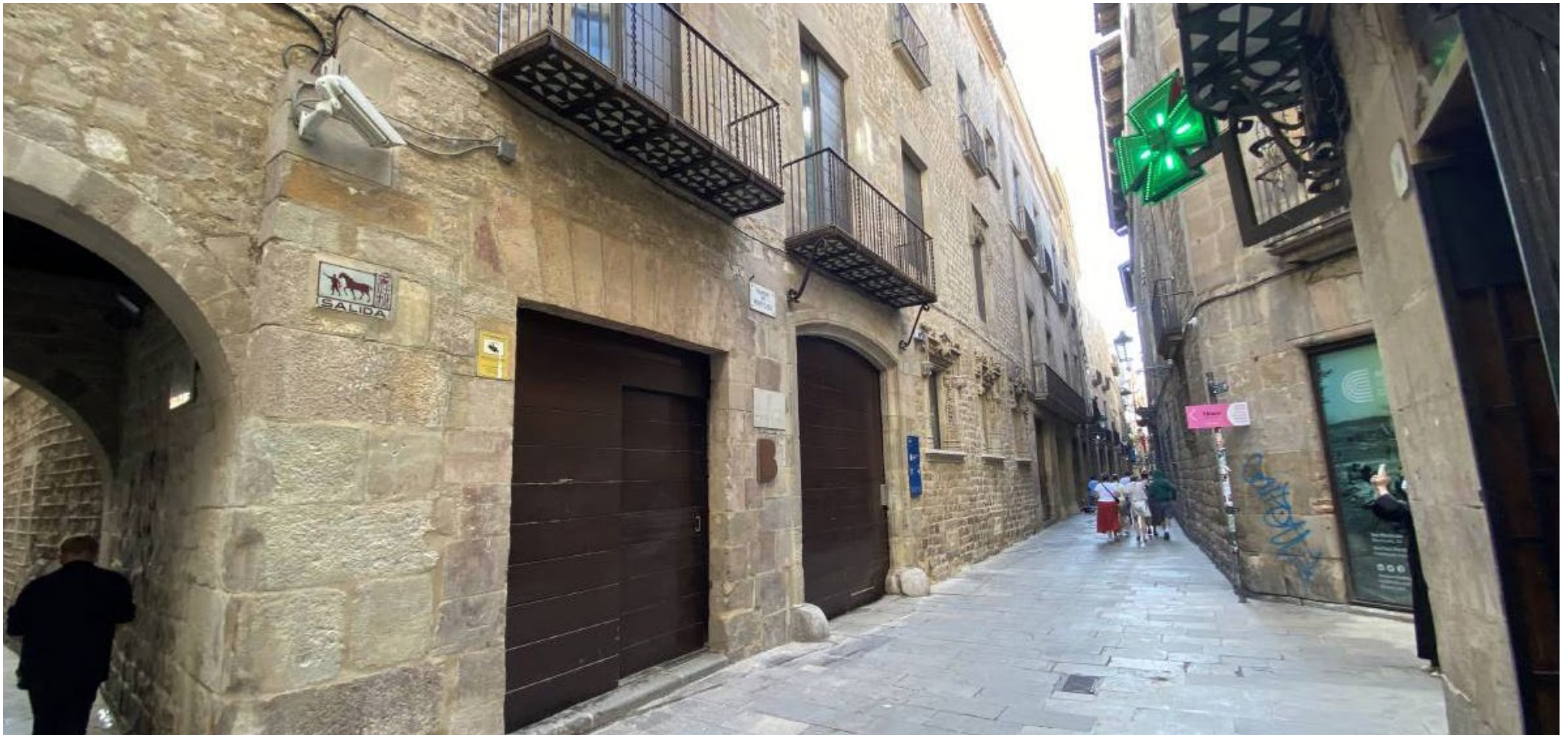
Museu Picasso. Rehabilitació façana
