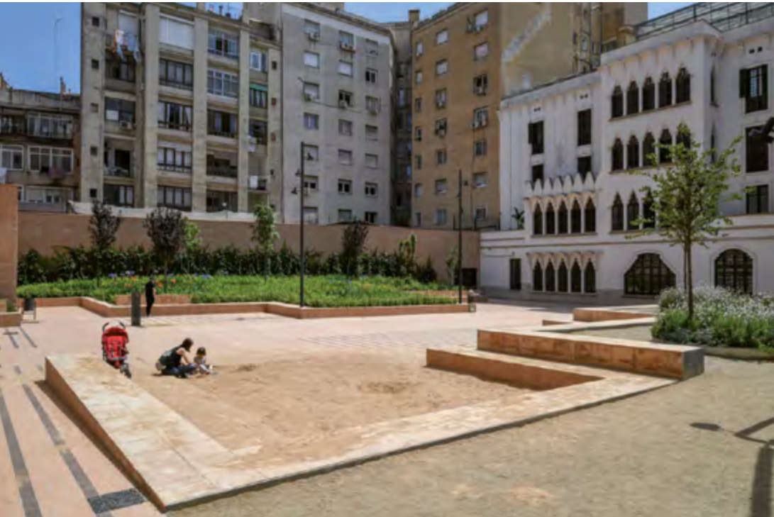
Reurbanització de l'espai interior d'illa de la Casa Macaya. Eixample
