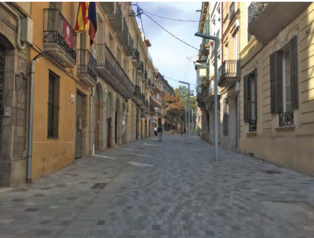
Reurbanització del carrer Major de Sarrià. Sarrià-Sant Gervasi
