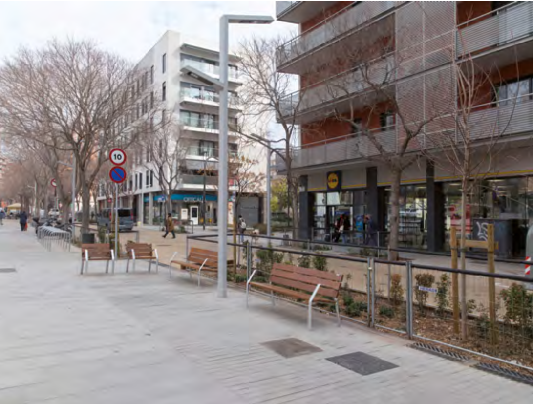
Reurbanització del carrer Gran de Sant Andreu. Sant Andreu
