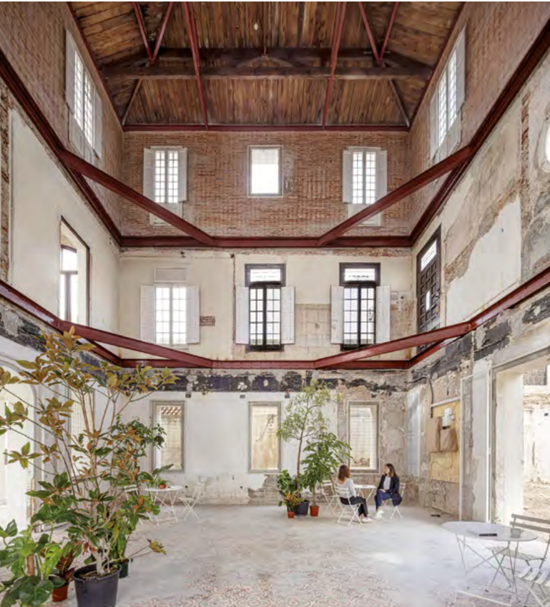
Adequació de l'antiga casa Canals i Junyer. Gràcia
