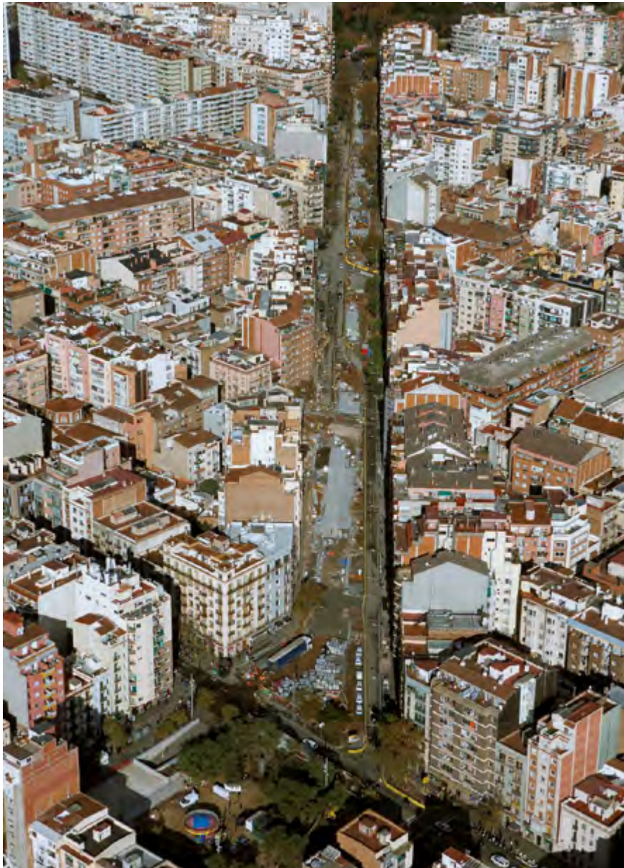
Transformació del carrer de Pi i Margall (en execució)
