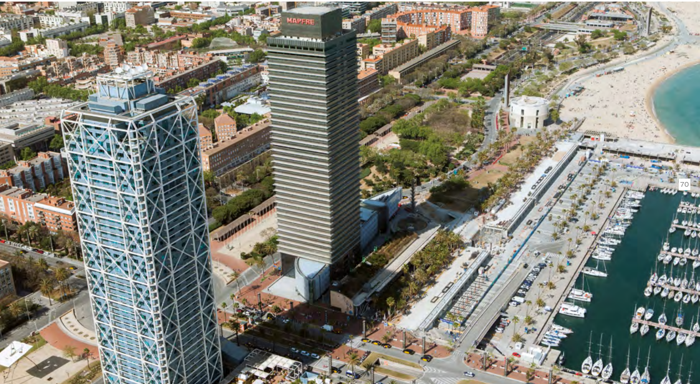
Port Olímpic: construcció del nou accés i adequació dels locals del moll de Mestral
