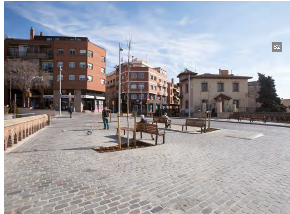
Reurbanització de la plaça de Mons. Gràcia
