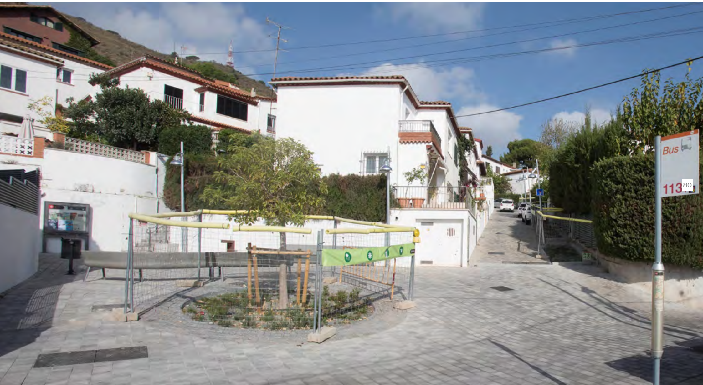
Reurbanització de la plaça Coll de Finestrelles i entorns. Les Corts
